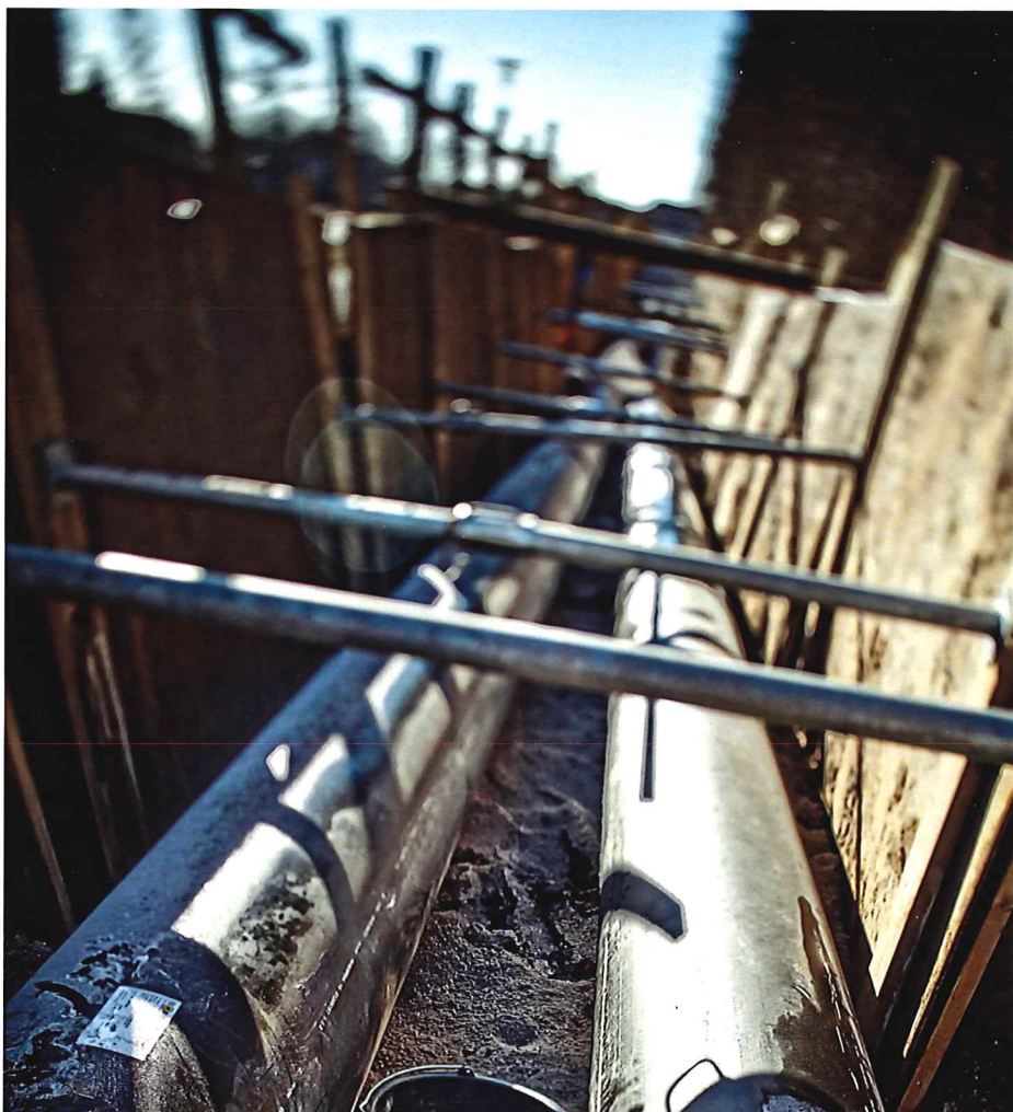
VEKS' system omfatter i alt cirka 134 km dobbelttrør. Dertil kommer systemet i Køge - her ved et tidligere anlægsarbejde. Foto: Peuckert Photography
